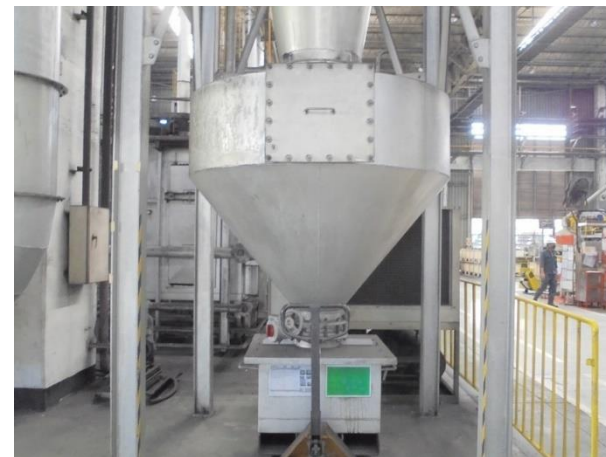
รูปที่ 2-38 Big bag เพื่อรองรับฝุ่นละอองจาก Cyclone และมีตัวปิดมิดชิด เพื่อป้องกันการฟุ้งกระจาย
